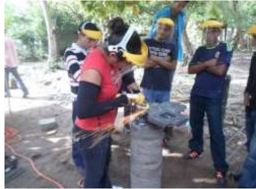
Una joven participa en una de las sesiones de práctica del curso de soldadura móvil en el municipio de San Luis La Herradura en el departamento de La Paz, El Salvador.
